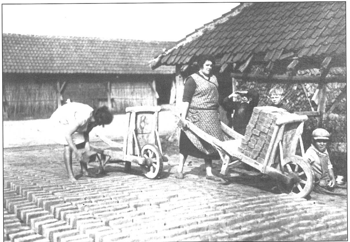
13. Steen "uitdoen" is het oprapen, wegvoeren en gammen van de afgedragen stenen. De gammer die met de wagen wegrijdt, wordt hier geholpen door een meisje, waarschijnlijk haar dochter, die hielp omdat ze blijkbaar niet naar school moest (Fotoarchief Gemeente Boom nr. 5059).
