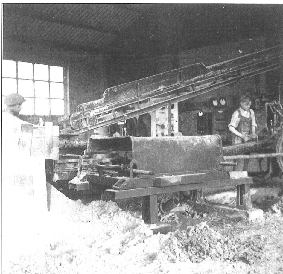
1. Beginnende mechanisatie in de baksteenproductie, het snijden van de klei gebeurde voortaan met deze machine. Let op de vrij jonge leeftijd van één van de medewerkers (Foto Roger Deschacht.).
