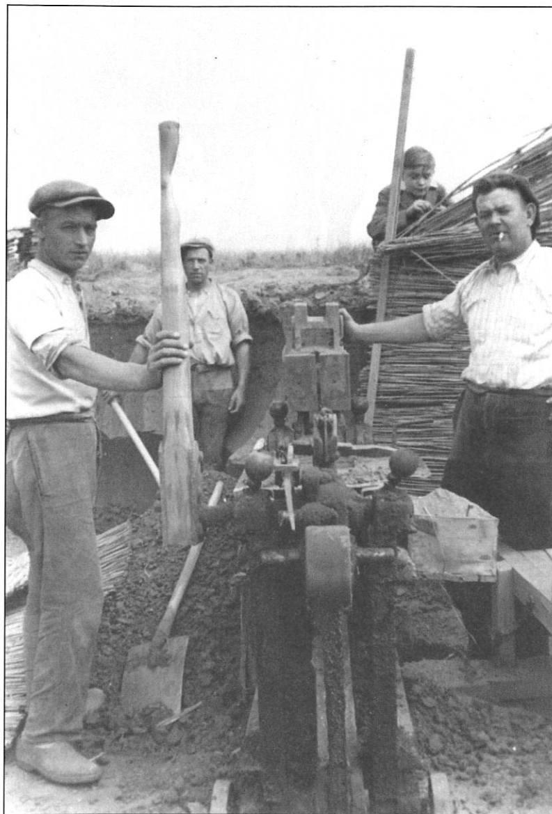
1. Het persen van de klei tot de vorm van de baksteen in de jaren dertig (Foto familie De Wint, Erondegem).
