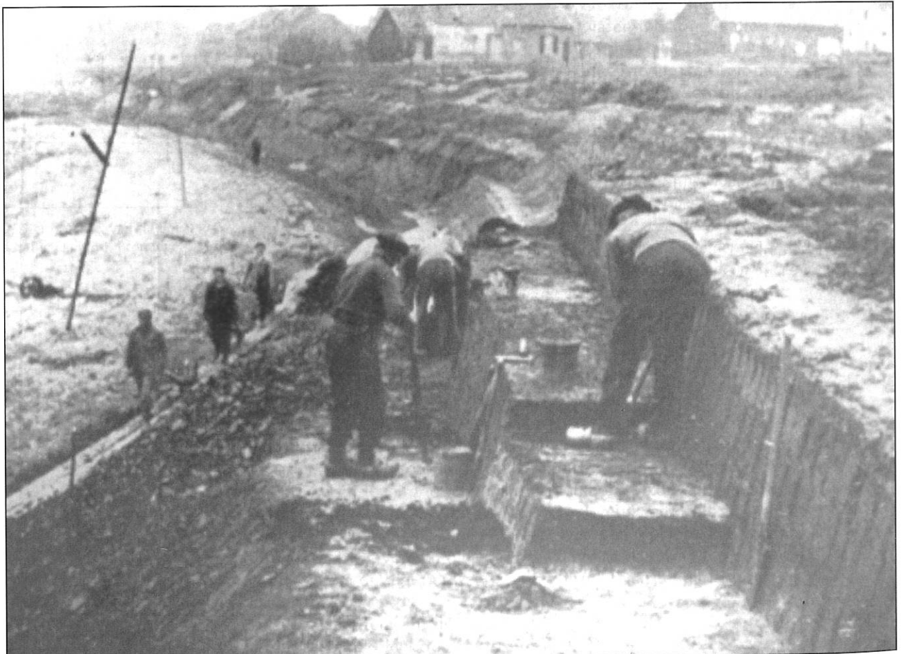
1. De grote mannen steken de bovenste speten (uit: C. Camerman en Baeyaert, De Boomse baksteen (Brussel, 1950) p. 8).
