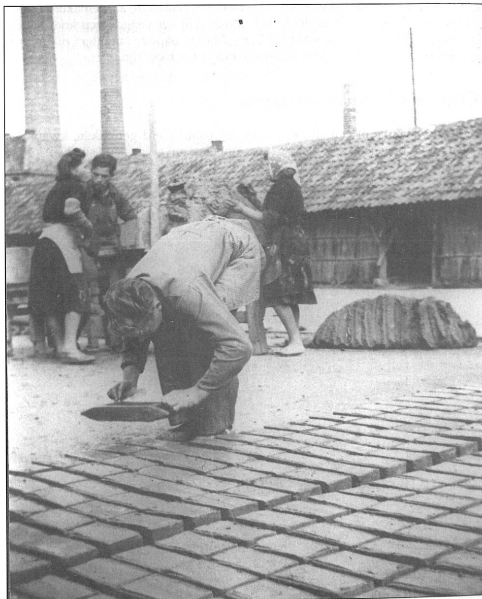
3. De afdrager tikte de afgedragen steen nog eens aan met de houten vorm als deze al op de grond lag. Dat was nodig om de bramen weg te drukken die ontstonden bij het uit de vorm vallen. Door dit aantikken ontstonden de typische randen van de handsteen (Fotoarchief EMABB).
