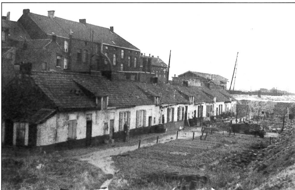
2. De “Waterroot” te Boom, gesloopt in 1928. Typische arbeiderswoninkjes met een stukje land erbij, gebouwd op een uitgegraven terrein door de steenbakker. Er was geen afwatering mogelijk, omdat het terrein te laag lag. De volkse benaming van deze straat drukt een hoop waterellende uit. Huishuur en pacht voor het tuintje werden afgetrokken van het arbeidsloon, zie ook de bijlage met uitbetalingen (Fotoarchief Gemeente Boom nr. 0334).
