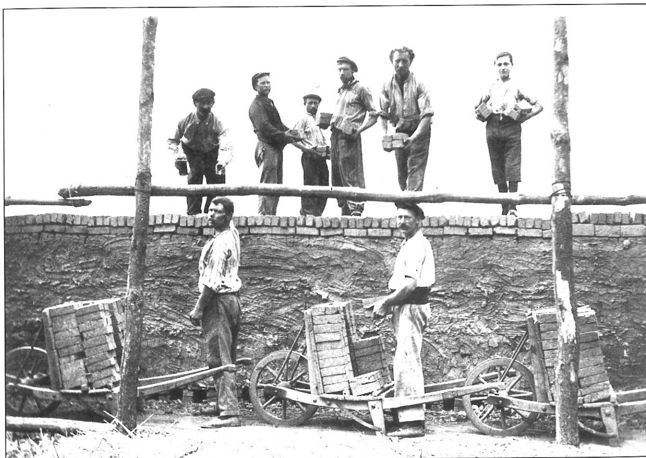
6. De bouw van een veldoven op de Hulstberg te Meerbeek. De stenen werden aangevoerd met typische kruiwagens, afgeladen en in ketting doorgegeven aan de werkmakers die de kleiklompjes zorgvuldig stapelden. Behalve de schoorsteenmonden zijn de wanden tot op schouderhoogte met leem of klei beplakt. De eerste voerman maakte van de pauze gebruik om vlug een glas te ledigen (Heemkring Comité 1000 jaar Meerbeek).
