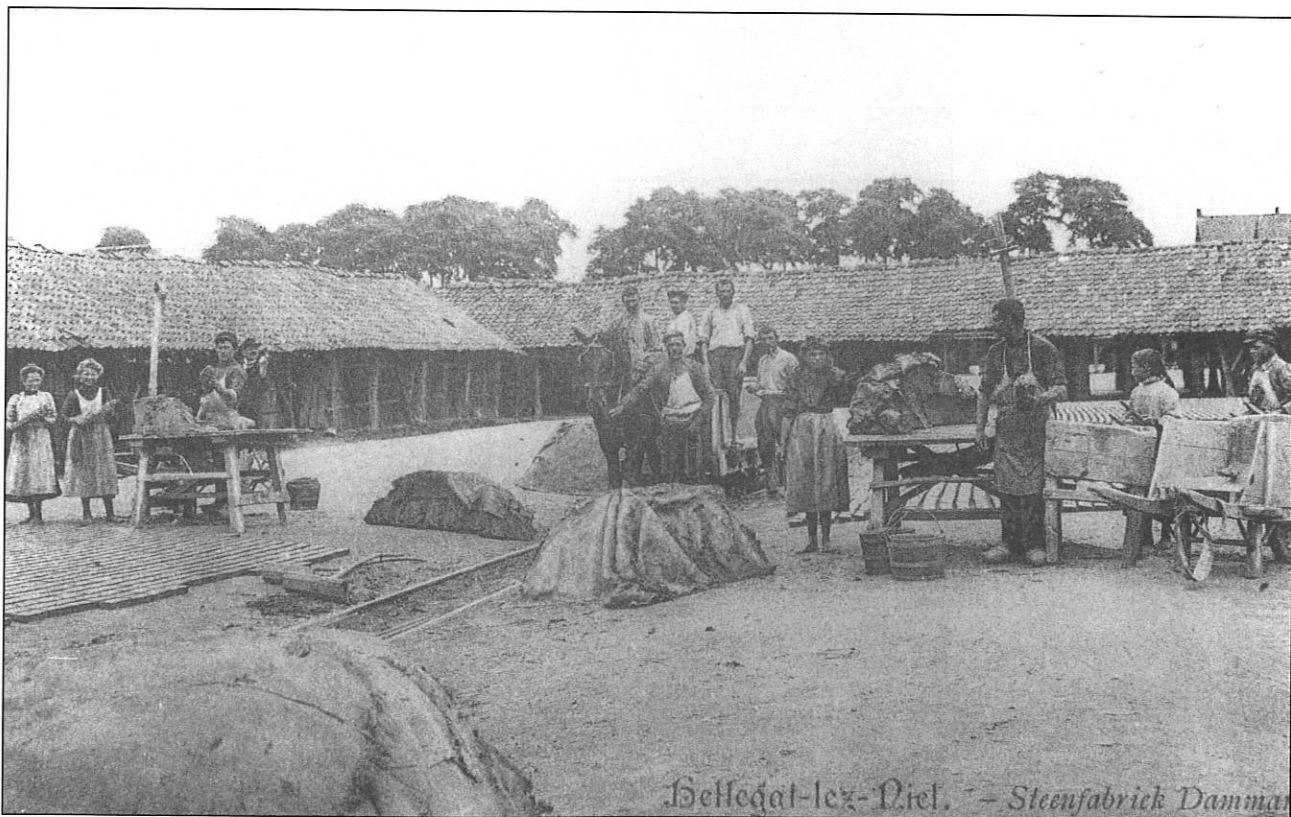
2. De twee steenmakersploegen op de "plaats" van steenbakkerij Damman te Niel omstreeks 1900. De linkerploeg werkte van achter naar voor, de rechter van voor naar achter. De afgeladen steenaarde, afgedekt met zakken, ligt klaar voor het vervolg. Op de steenmakerstafel de opgezette aarde, in het midden het spoortje met de voerman en zijn paard (Postkaartenverzameling Eduard Wilssens, Schelle).
