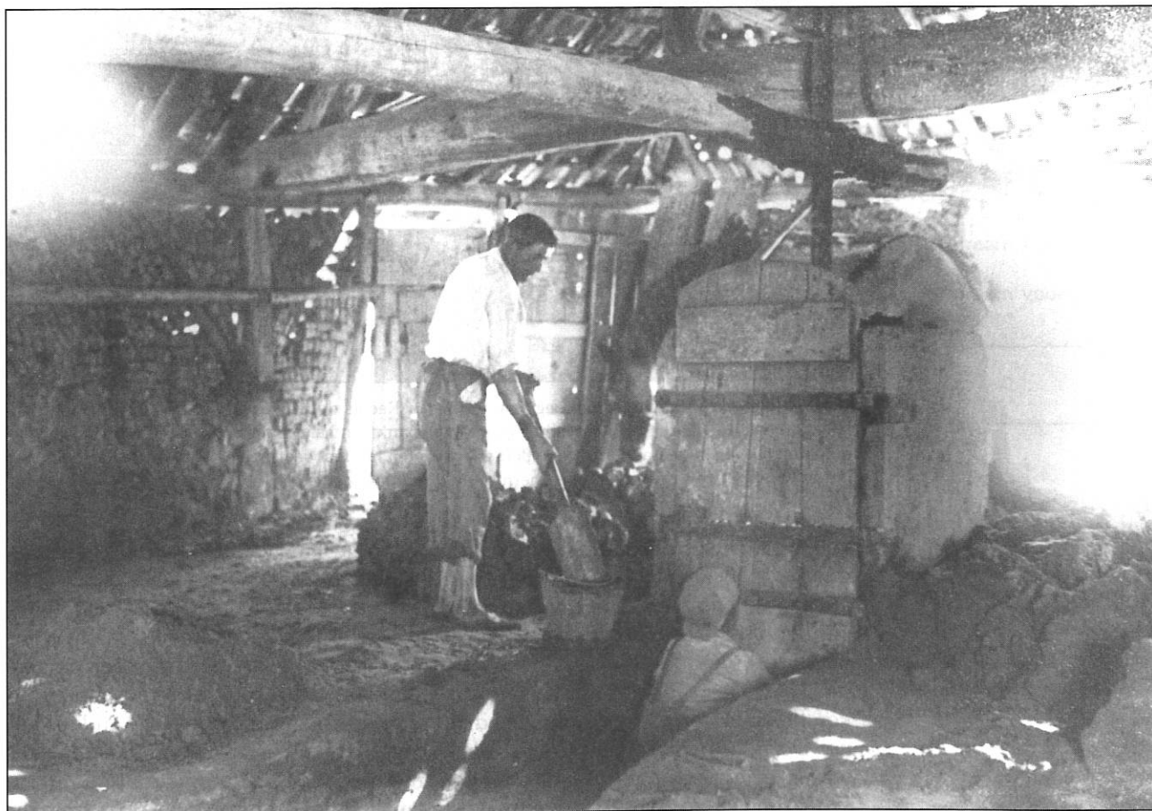
14. In het molenhuis van de respotaardemolen. Links de "inlegger" met de "houten schup" en een "dop", rechts in de "molenput" de "uitdrager", die de "kloeten" of "stuiken" "uitdroeg" (Fotoarchief Gemeente Boom nr. 5085).
